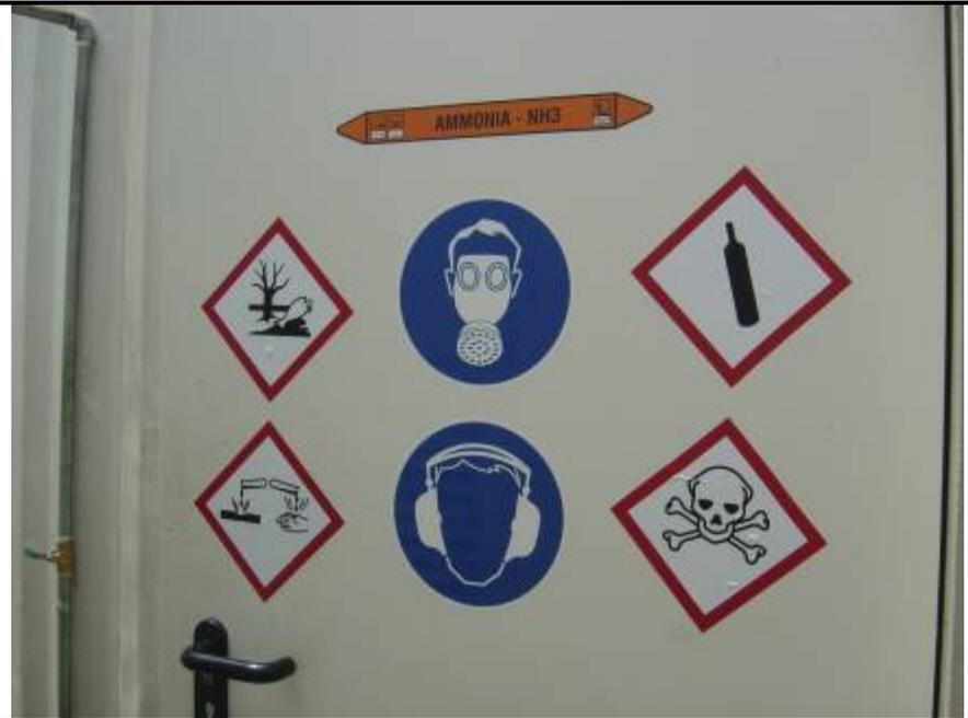
18. Vista de cartel indicando requerimientos de EPP en la planta de amoníaco del sitio de esclusas PAC/ View of sign indicating required PPE use at the ammonia plant of the PAC locks site.
