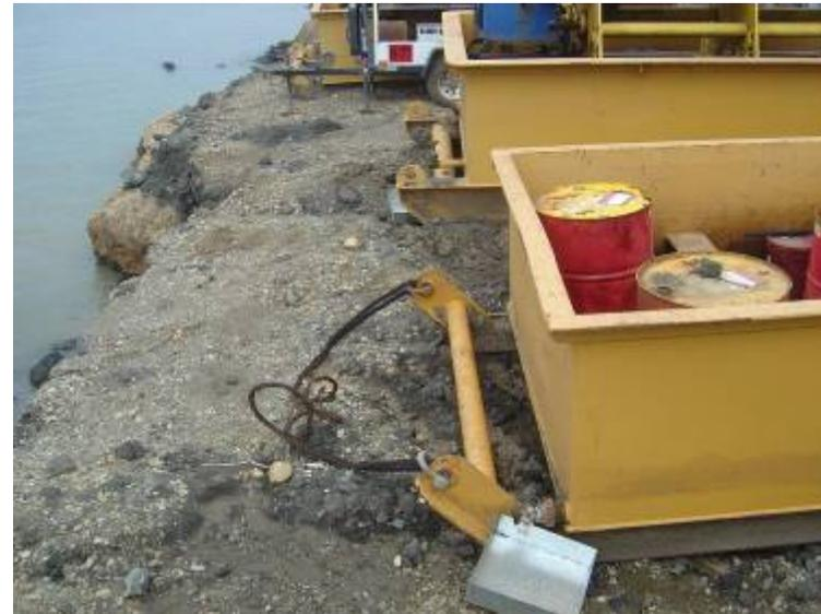
4. Vista de tanques de almacenamiento de diesel con contención secundaria en la bordada Mamey. / View of diesel storage tank with secondary containment at Mamey Reach.
