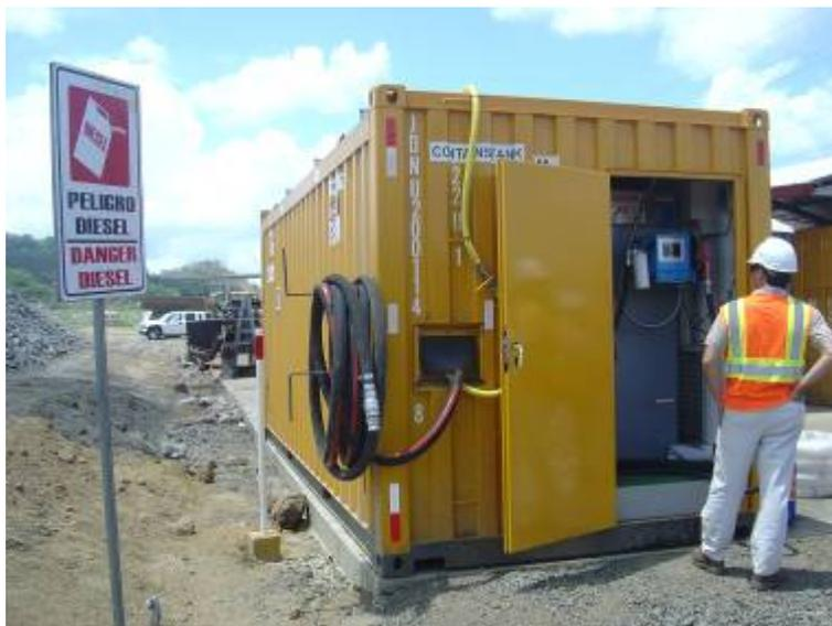
5. Vista de tanque de almacenamiento de diesel con contención secundaria en contenedor de doble pared en CAP 0/ View of diesel storage tank with secondary containment in double-walled container at PAC 0.
