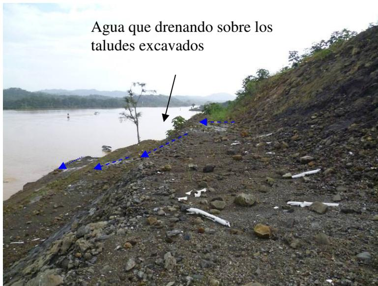
Fotografía 4. Vista del agua drenando sobre los taludes
