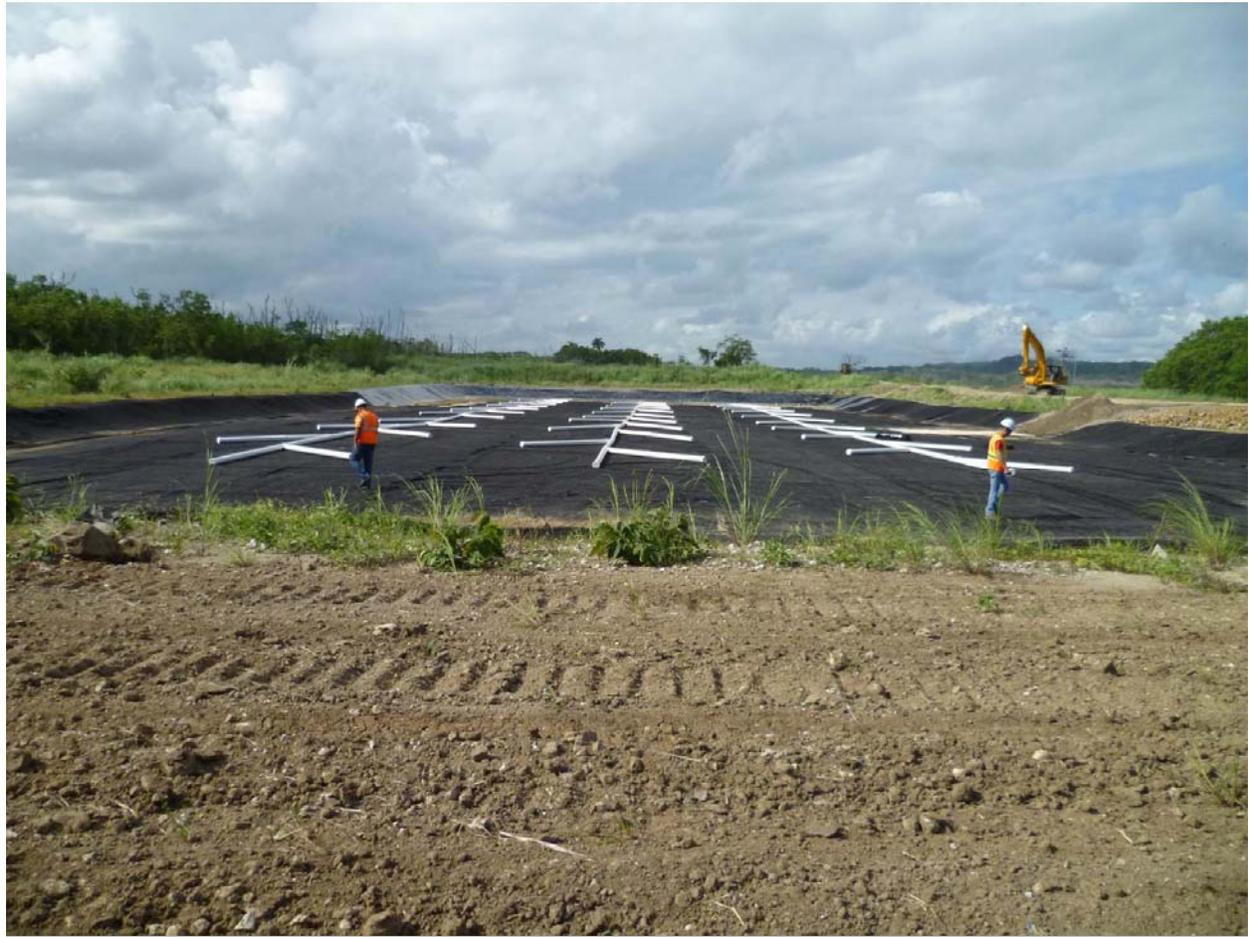
**Foto No. 8:** Instalación del sistema de drenaje en la unidad de tratamiento.
