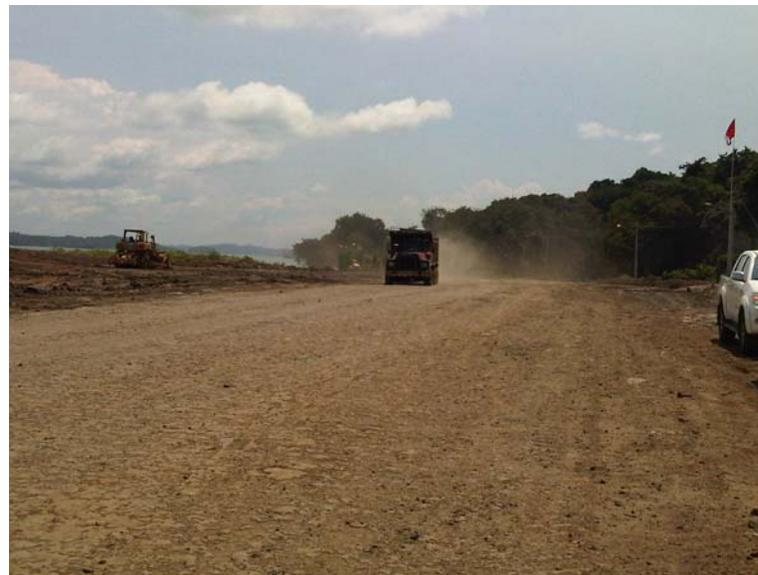
19. Vista de camión con tolva cubierta para evitar la diseminación de polvo y objetos (GUPCSA)./ View of truck with covered dump bed to avoid flying dust and objects (GUPCSA).
