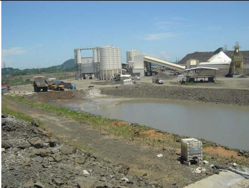
22. Vista de las tinas de sedimentación para el manejo de agua superficiales en GUPCSA PAC / View of sedimentation lagoons for surface water management at GUPCSA PAC.
