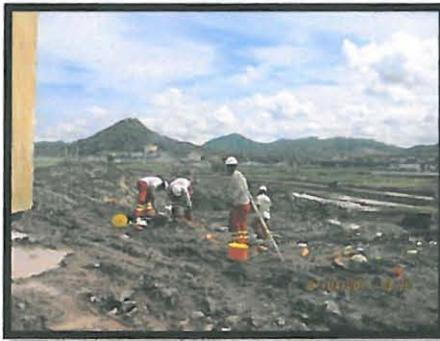
Utilización de los guantes y demás equipos de protección durante la manipulación de productos químicos y trabajos de carga de barrenos
