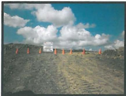
Señalización preventiva durante los procesos de carga de barrenos restringiendo el paso al personal no autorizado para trabajos de voladuras.
