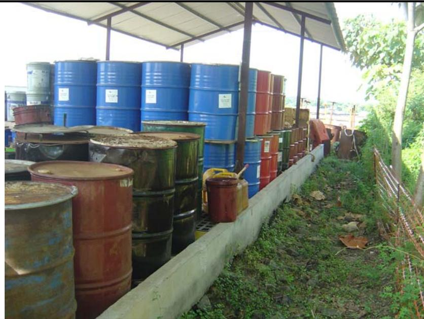
13. Se observó algunos envases almacenados sobre el borde de la contención en el área de Velazques de DI/ Some containers were observe on the edge of the secondary containment at the Velazques area of DI.
