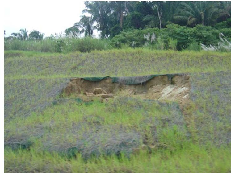
4. Vista de un pequeño deslizamiento de un talud revegetado. / View of a small landslide on a revegetated slope.
