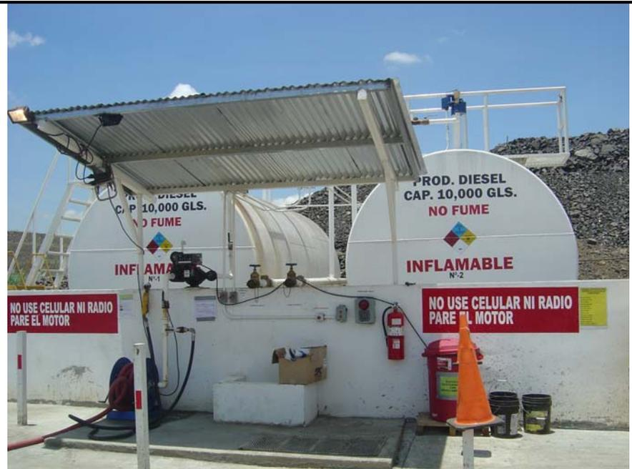
11. Vista del equipo y medidas de control de derrames e incendios en la zona de combustibles del CAP0 / View of spill and fire control equipment and measure at the PAC0 fueling area.
