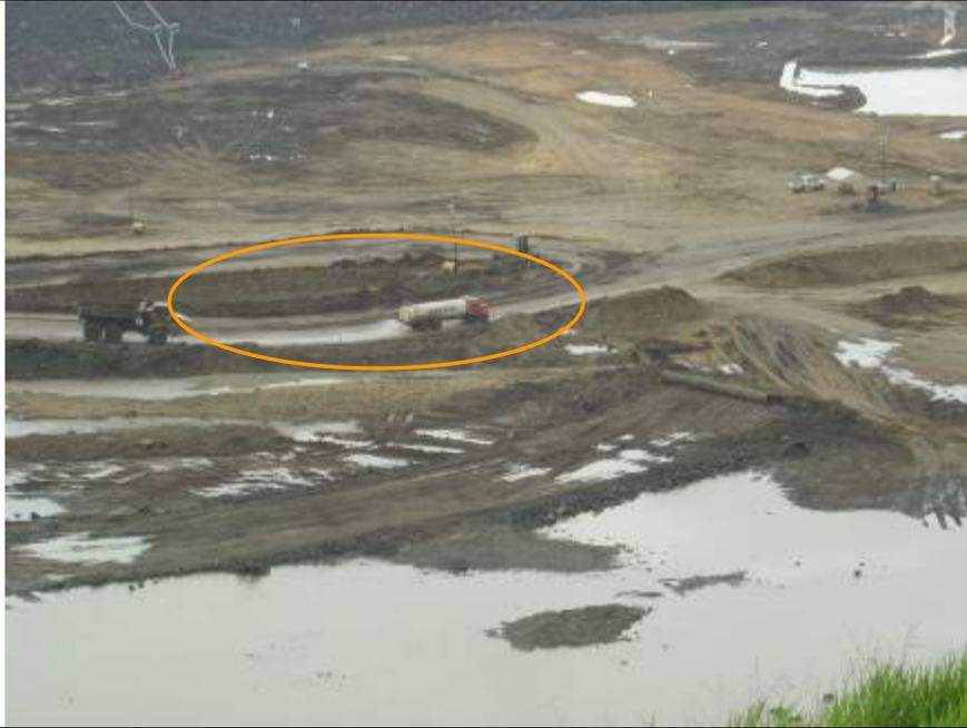
1. Evidencia del uso de camiones cisternas rociando agua para el control de polvo. / Evidence of the use of water trucks spraying water to control dust.
