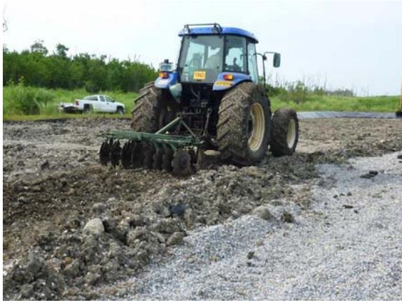
**Foto No. 13:** Fertilización y aireación del suelo en tratamiento
