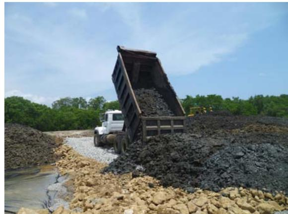
**Foto No. 12:** Disposición de suelo contaminado en Tina de Telfers
