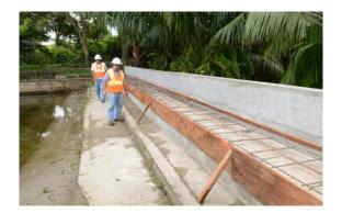
Modificación # 1 : 15/oct/2012 B/. 262.48 Losa de concreto de 3000PSI de 2.3m X2.3m x 0.10m reforzada con barras#3 @ 0.45m, en ambas direcciones, en el área de la caseta fregadero en Lagarterita #3.
