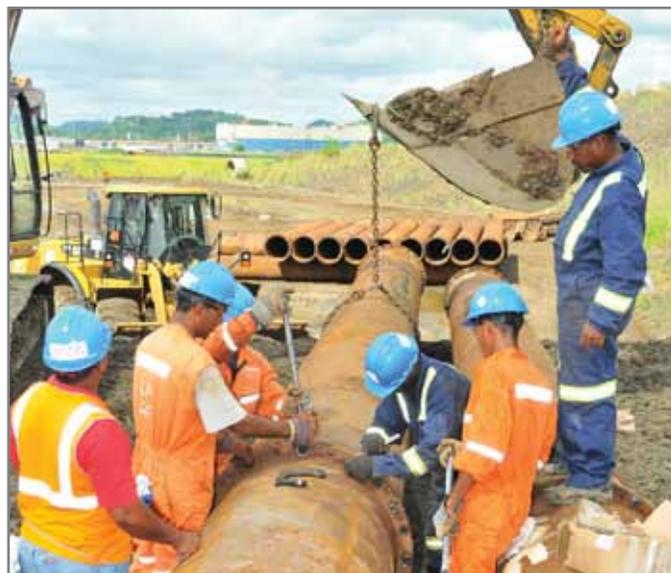
Instalación de las tuberías de dragado en el sitio de depósito del PAC-4.
