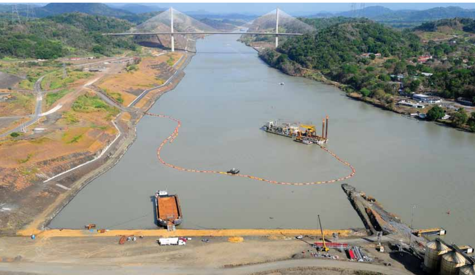
Dragado en la entrada norte del Cauce de Acceso del Pacífico.
