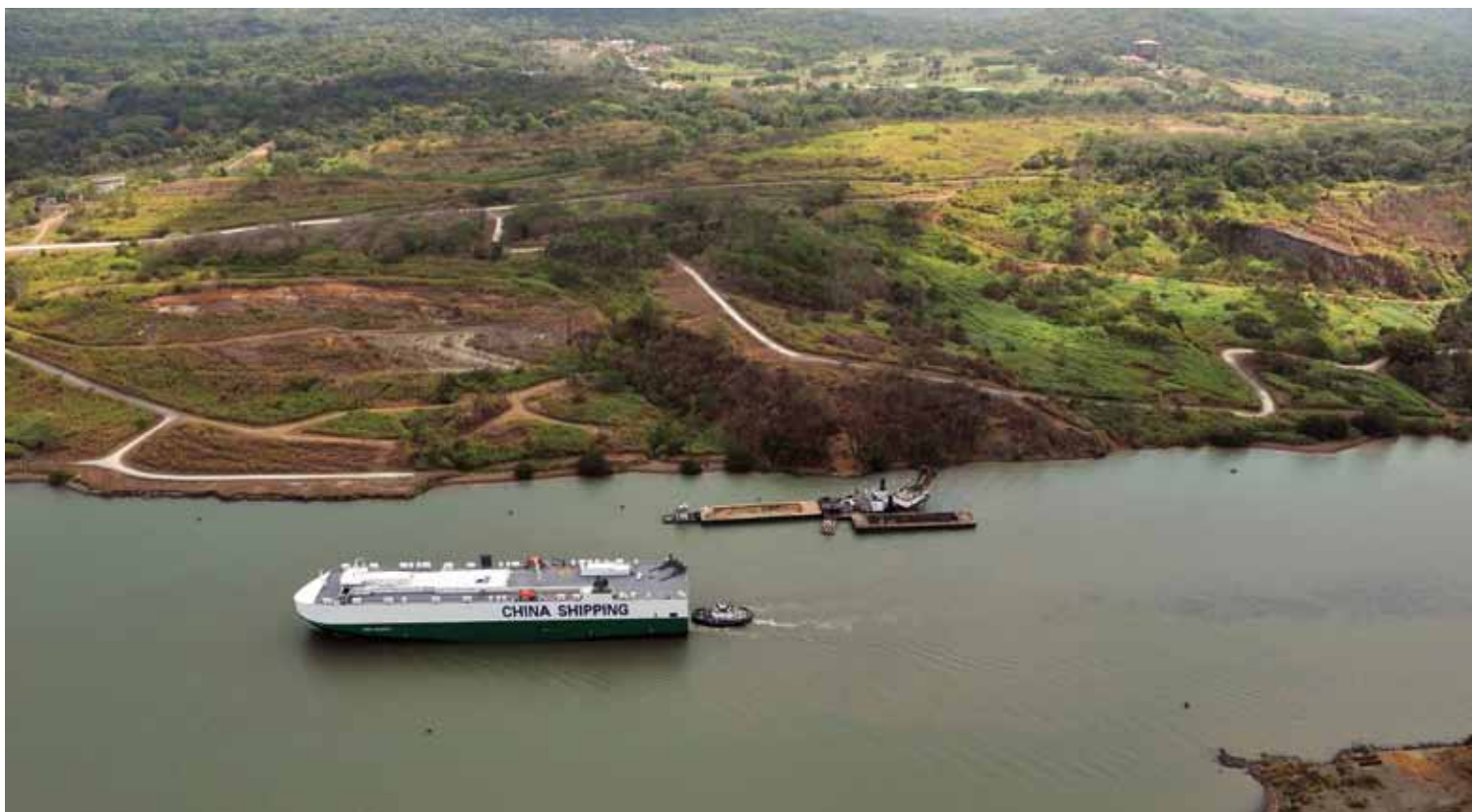
Draga Christensen durante trabajos en el Corte Culebra.
