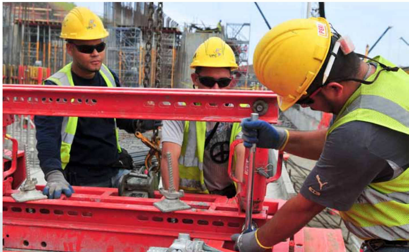
Armado de formaleta para vaciado de concreto en el área de las nuevas esclusas del Pacífico.
