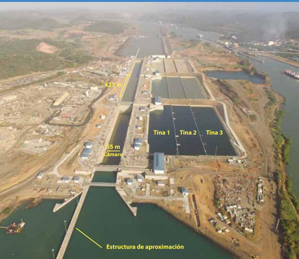
Esclusa de Cocolí, en el Pacífico, durante el proceso de llenado de las tinas de reutilización de agua como parte de las pruebas de funcionamiento.
