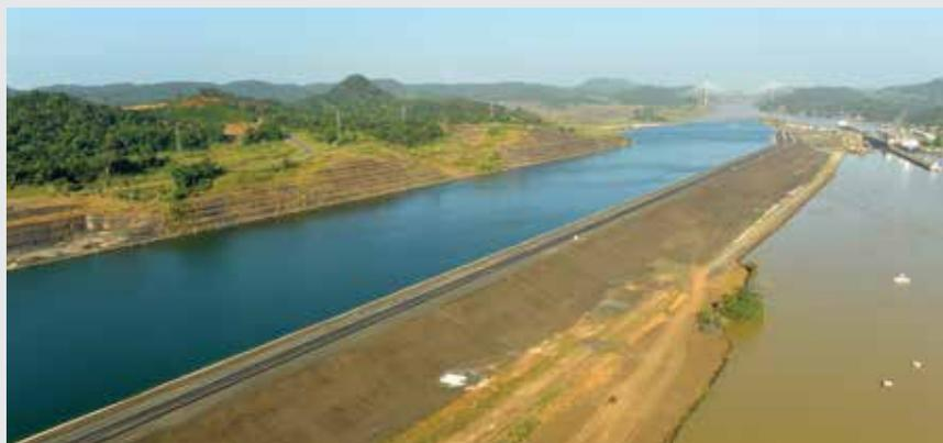
El cauce tiene 6.1 kilómetros de longitud y 218 metros de ancho, y su fondo de excavación se encuentra a 9.14 metros sobre el nivel del mar.
