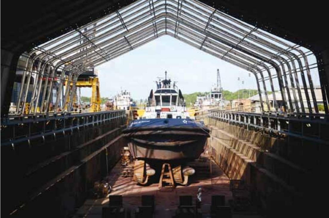
La tarea forma parte del mantenimiento de la flota de remolcadores del Canal y esta fase en especial consiste en atender todos los sistemas que están por debajo de la línea de flotación de las embarcaciones.
