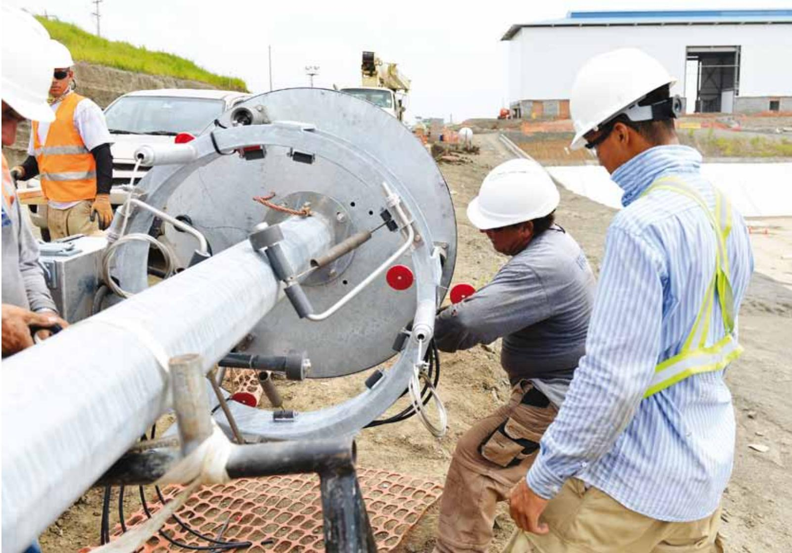
Los instaladores montan el anillo y sus accesorios antes de levantar el poste.
