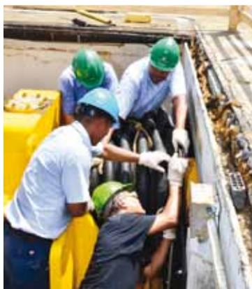
En apariencia igual, pero en esencia muy cambiado. Botas de caucho protegen los brazos hidráulicos para evitar el paso del agua.
