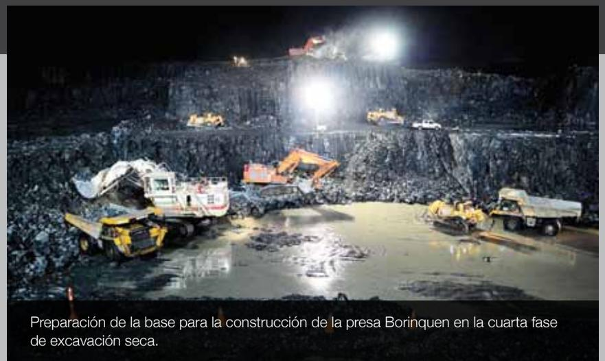
Preparación de la base para la construcción de la presa Borinquen en la cuarta fase de excavación seca.
