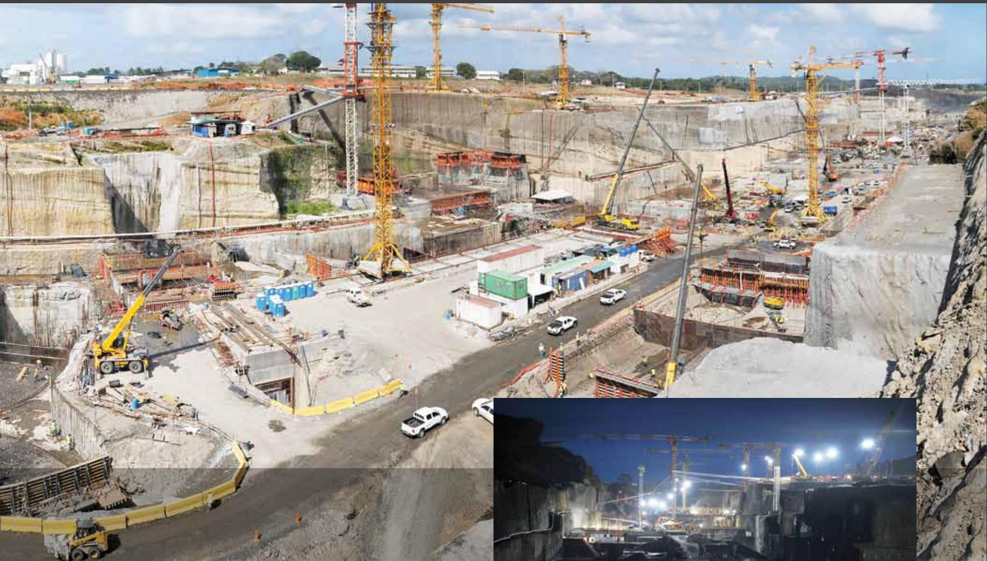
Construcción en la cámara media de las nuevas esclusas de Gatún. Al terminar el proyecto se habrán removido 16 millones de metros cúbicos de material y se habrán vertido 2.2 millones de metros cúbicos de concreto.
