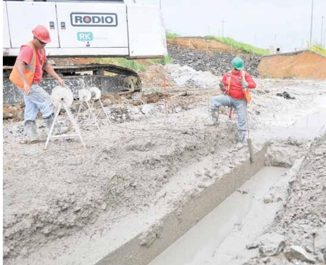
El subcontratista construyó una pantalla de 458 metros lineales en los que se utilizaron 4,875 metros cúbicos de cemento y bentonita. La mezcla debió cumplir con la resistencia y permeabilidad requeridas a los 28 días de haberse producido, tal como lo establece el contrato.
