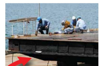
Trabajos de limpieza y soldadura en una de las compuertas en el muelle 45
