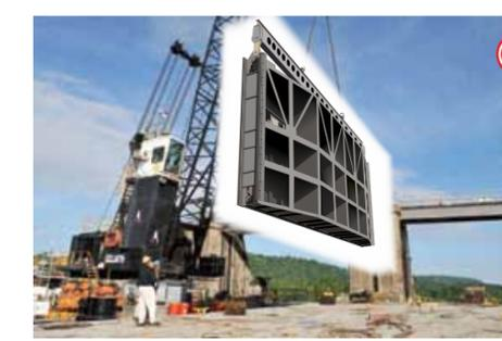
**9** Las compuertas con las extensiones es transportada de vuelta al vertedero para colocarla en su nicho e instalar los componentes mecánicos.
